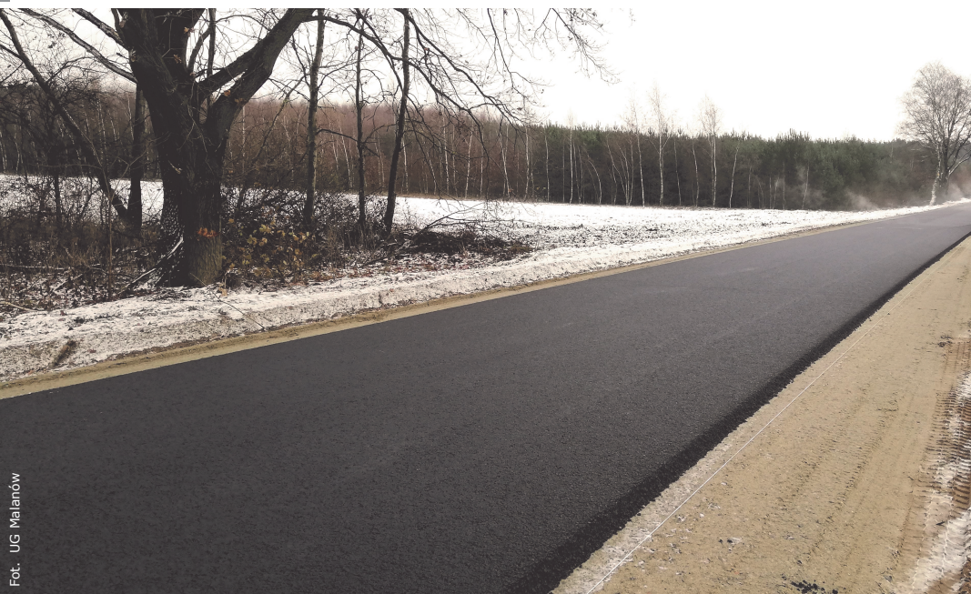
Przebudowana droga Skarżyn-Kolonia — Czachulec Stary
